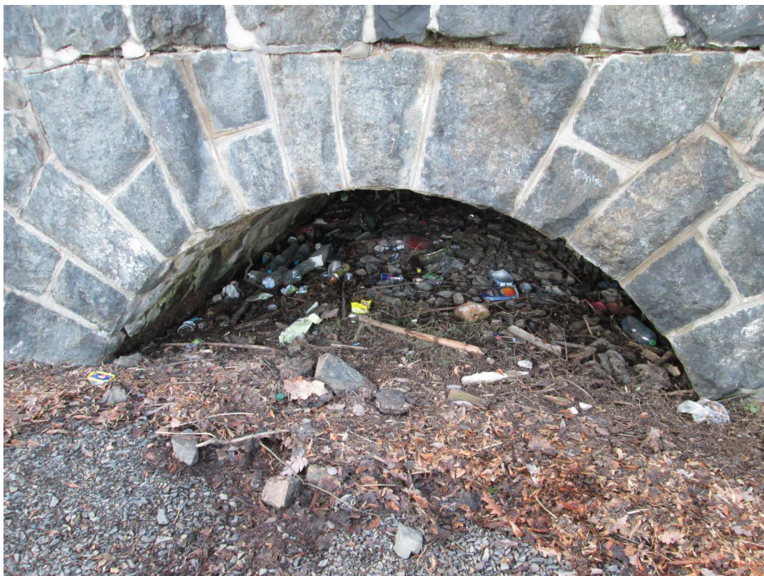
Mostní otvor zprava. Silné nánosy.
